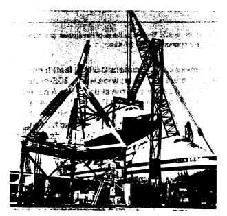
Figure 6-15.—Mate/demate stiffleg derrick (108- KSC-7PC-34).
